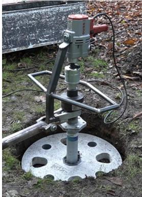
Neben aufgeständerten Pfahllasten kann das paXos RFS auch bei **Baulasten (BL)** eingesetzt werden, um z.B. Container oder Fertigbauten zu gründen. Hierbei verteilt sich die Gewichtslast durch einen speziellen Aufsatz ideal auf die Fertigbetonplatte, wodurch bis zu **16 Tonnen Last** pro Fundamentplatte aufgenommen werden können.
