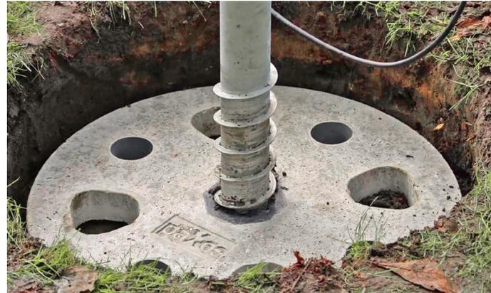
Mit dem paXos Rapid-Fundament-System (RFS) wird das Baumwurzelprinzip imitiert. Zentrale Pfahlwurzeln nehmen hohe Zugkräfte auf und Flächenwurzeln die Biege- und Schubkräfte. Das RFS kombiniert daher eine Erdschraube, welche die Zugkräfte aufnimmt, mit einer biegesteifen Fertigbetonplatte, die knapp unterhalb der Grasnarbe eingebracht wird und die Biege- und Schubkräfte aufnimmt.
